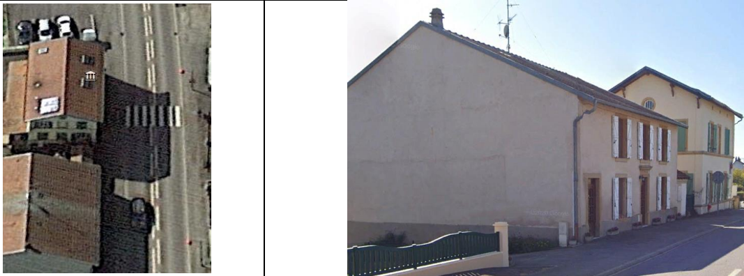
Faitage parallèle à la rue. Toiture à double pan en tuiles teinte rouge.
